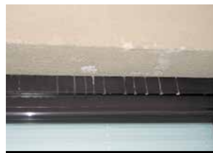
Fot. 1. Wyptyw kropli pod ościeżką okna pod balkonem/tarasem może świadczyć także o błędach w ociepleniu ściany Fot. M. Rokieli
