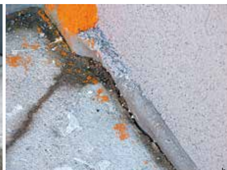
Fot. 5a, b. Nieprawidłowe wykonanie jastrychu skutkuje często spękaniem pojawiającymi się jeszcze przed ułożeniem okładziny ceramicznej. Uniemożliwia też poprawne wykonanie i uszczelnienie dylatacji obwodowych oraz wpustów. Taka sytuacja wymaga często usunięcia wszystkich warstw, aż do płyty nośnej Fot. M. Rokiel
