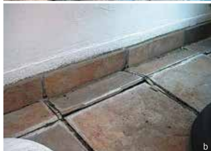
Fot. 3. Wynik zbyt dużego rozstawu dylatacji (a), oraz sytuacji, gdy płytki cokolika zachodzą za płytki balkonu (b) Fot. M. Rokiel
