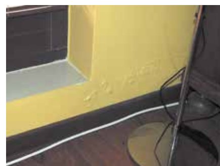
Fot. 2. Zawilgocenia strefy cokołowej w pomieszczeniu mogą sugerować błędy w uszczelnieniu styku połaci ze ścianą. Przyczyną jednak mogą być także błędy w termoizolacji połaci ze ścianą Fot. M. Rokieli
