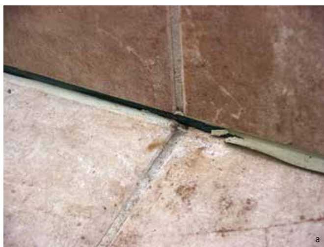
Fot. 7. Uszkodzenie dylatacji brzegowej na skutek zbyt dużych ruchów termicznych i niewłaściwego nałożenia masy dylatacyjnej (a). Uszkodzenia spoin na skutek błędów w wykonaniu dylatacji (b)
