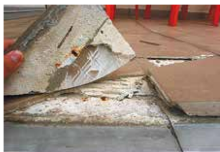
Fot. 4. Przyczyną uszkodzeń może być złe zamocowanie obróbek blacharskich i/lub zbyt głębokie wsunięcie ich pod okładzinę ceramiczną Fot. M. Rokiel
