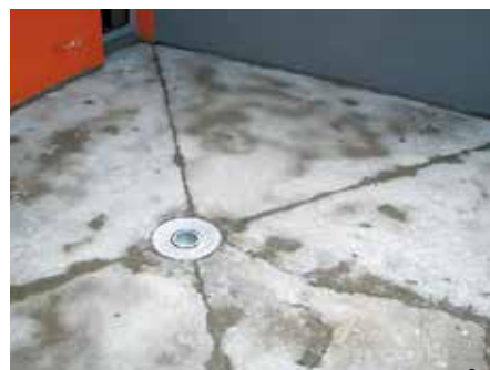
Fot. 5a, b. Nieprawidłowe wykonanie jastrychu skutkuje często spękaniem pojawiającymi się jeszcze przed ułożeniem okładziny ceramicznej. Uniemożliwia też poprawne wykonanie i uszczelnienie dylatacji obwodowych oraz wpustów. Taka sytuacja wymaga często usunięcia wszystkich warstw, aż do płyty nośnej Fot. M. Rokiel
