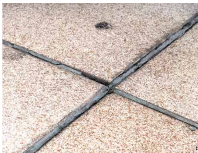
Fot. 7. Uszkodzenie dylatacji brzegowej na skutek zbyt dużych ruchów termicznych i niewłaściwego nałożenia masy dylatacyjnej (a). Uszkodzenia spoin na skutek błędów w wykonaniu dylatacji (b)
