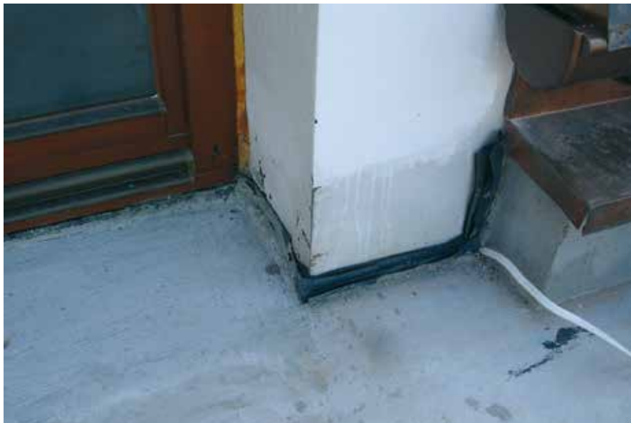
Fot. 6. Takie ułożenie papy nie może być traktowane jako wykonanie dylatacji obwodowej. Dodatkowo widoczny przewód elektryczny, którego uszczelnienie jest bardzo kłopotliwe. Brak koordynacji poziomów warstw w obszarze progu drzwiowego Fot. M. Rokiel
