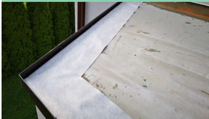
NAROŻNIK KĄT 129° - PROFIL W35+ - UKŁADANIE POSADZKI Z PŁTY NA WSPORNIKACH SMART
