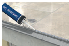
uszczelnienie dylatacji między profilami okapowymi a płytką
