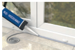
uszczelnienie dylatacji między posadzką a drzwiami
