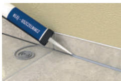
uszczelnienie dylatacji między posadzką a cokolikami
